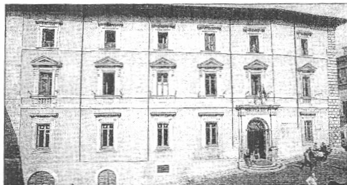
Palazzo Carli sede centrale dell'Università
