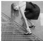
grata arrugginita sotto
